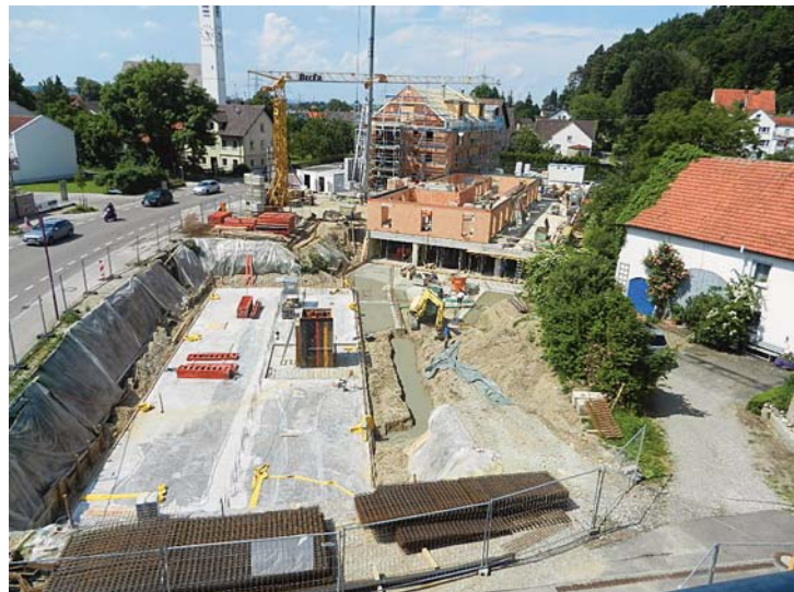
Die Gebäude in der Ortsmitte I wachsen täglich. Das nördlichste ist bereits im Rohbau erstellt, die Konturen des mittleren schon gut sichtbar. Auch die Umriss des südlichen Gebäudes sind aufgrund des Fundamentes schon erkennbar. Hier entstehen Mietshäuser und ein Haus, in dem Senioren eine neue Heimat finden können. Bild: Gemeinde.
