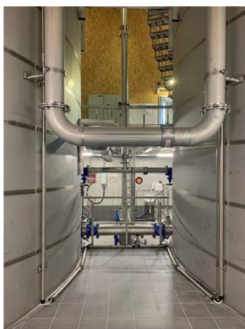
Blick ins Innere des neuen Hochbehälters.
