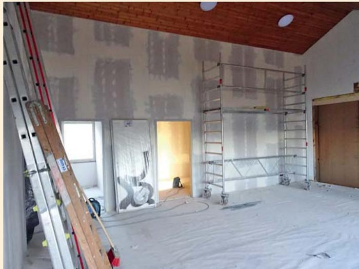
Trockenbau- und Verputzarbeiten sind im kompletten Bestandsgebäude bereits erledigt.
