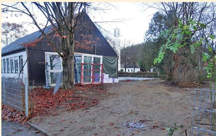
Der Um- und Neubau des Interimskindergartens ist in vollem Gange. Fensterausschnitte im Bestandsgebäude wurden gemacht und die Bodenplatte für den Neubau betoniert.
