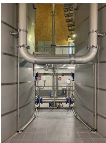
Blick ins Innere des neuen Hochbehälters.
