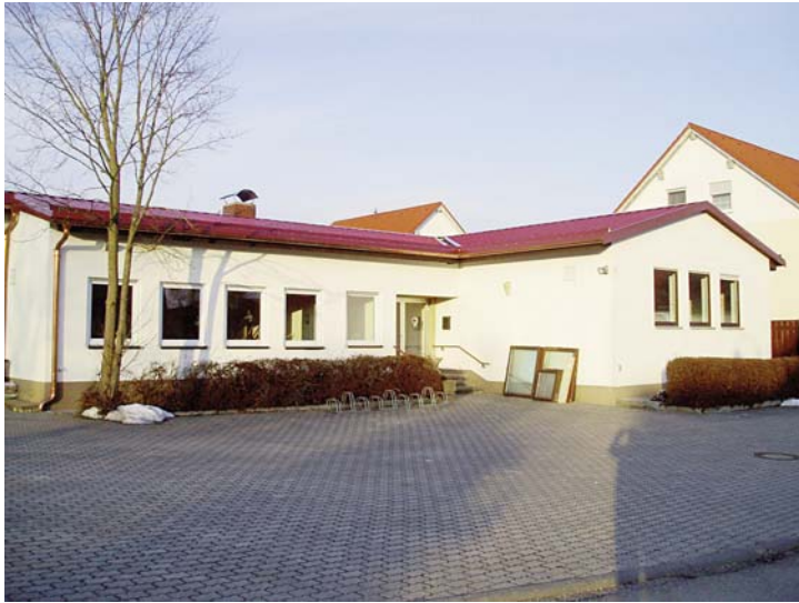
Unser Bild zeigt das Rot-Kreuz-Haus mit den neuen Fenstern und den ausgebauten, 40 Jahre alten Holzfenstern.
