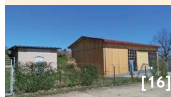
Bau des Hochbehälters
